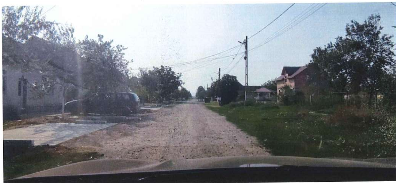
Foto 2. Zestre drum în stare bună, necesită scarificare și adaos din piatră spartă pentru planeitate
