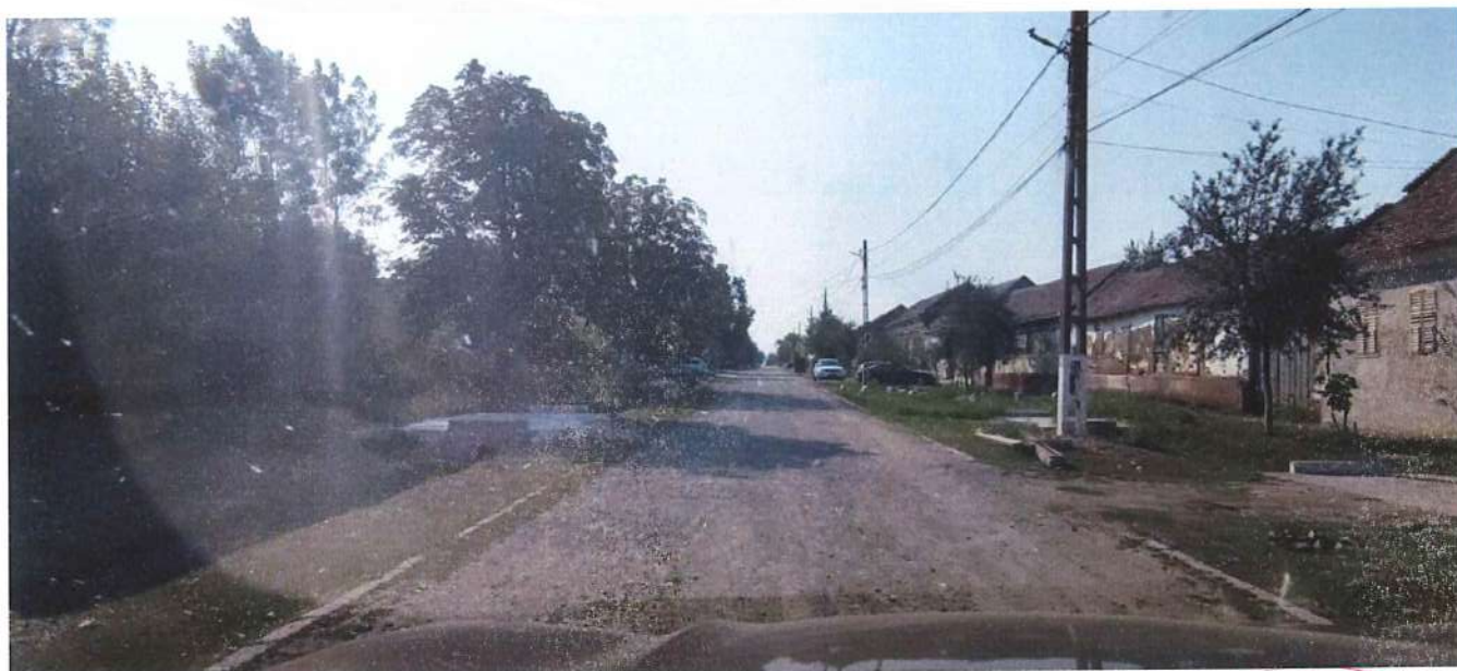
Foto 3. Zestre drum în stare bună, necesită scarificare și adaos din piatră spartă pentru planitate
